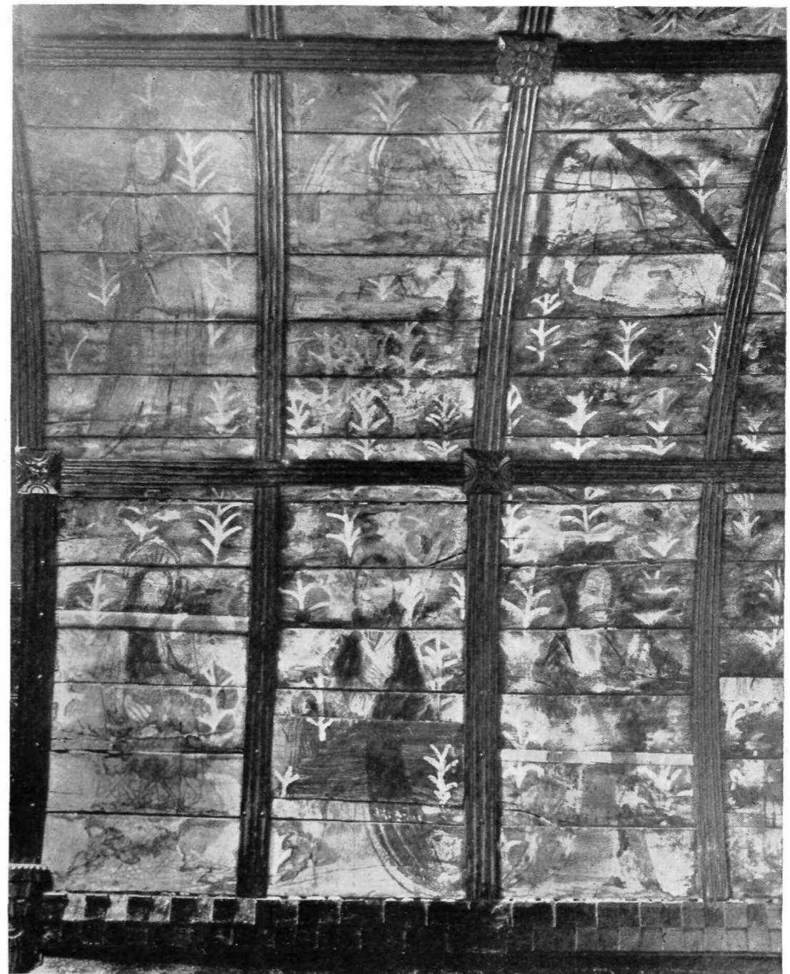
N. side of Chancel.
